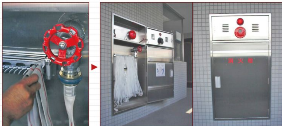
③改修用消火栓BOXを取付け、付属品取付け、配線処理を行ってください。
